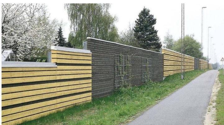
Rys. 9.15. Ekran przeciwhałasowy (cegła, drewno)
