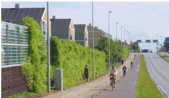
Rys. 9.16. Ekran przeciwhałasowy (przezroczysty, porośnięty roślinnością)
