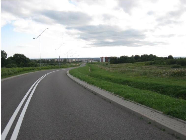
Widok ul. Jana Pawła II i południową część działek ewidencyjnych Nr 836/1 i 836/2
