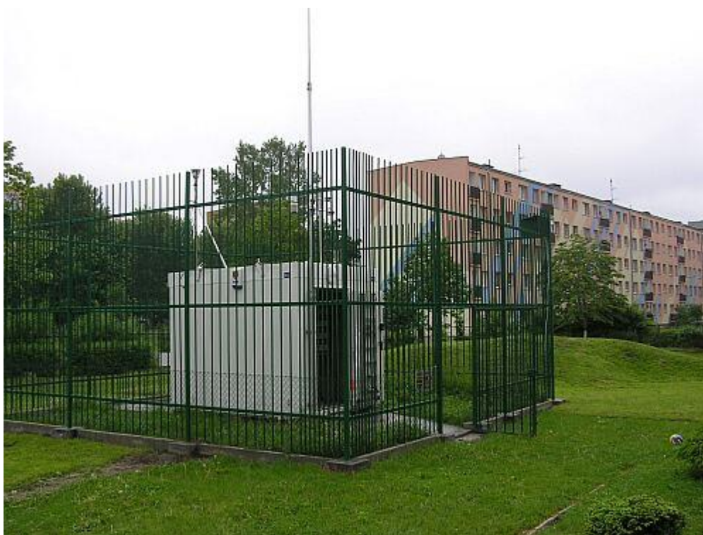
Rysunek 2-17 Lokalizacja automatycznej stacji pomiarowej przy ul. Bażyńskiego w Elblągu
