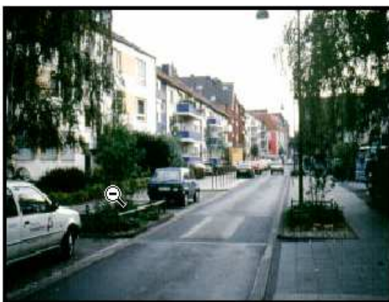
Rys. 10.9. Inne rozwiązania spowalniające ruch samochodowy. Estetyczna i przyjazna dla środowiska organizacja przestrzeni drogowej wymuszająca powolną i ostrożną jazdę. Rozwiązania szczególnie zalecane na obszarze osiedli z zabudową mieszkaniową.
