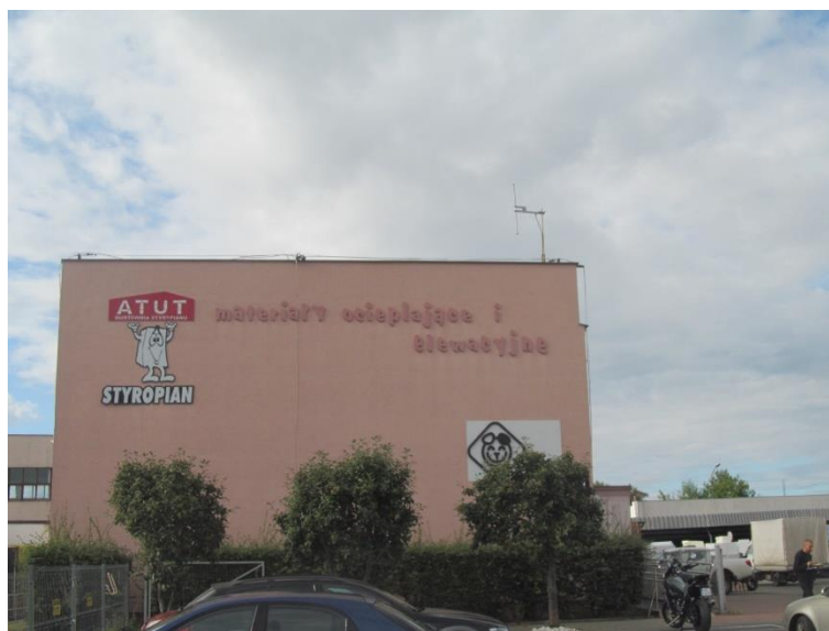
Załącznik nr 1: Widok anteny oraz widok ogólny instalacji radiokomunikacyjnej.
