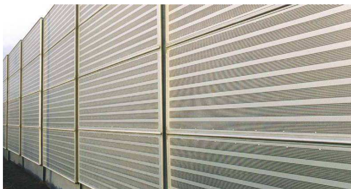
Rys. 9.17. Ekran przeciwhałasowy (dźwiękochłonny)
