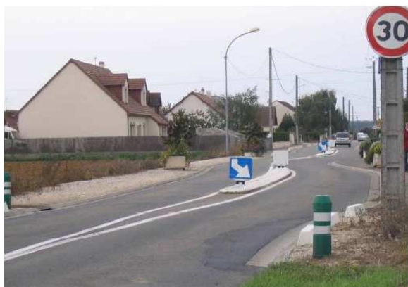
Rys. 9.7. Przewężenie na drodze – ograniczenie prędkości ruchu (źródło j.w.)
