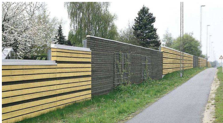
Rys. 9.15. Ekran przeciwhałasowy (cegła, drewno)
