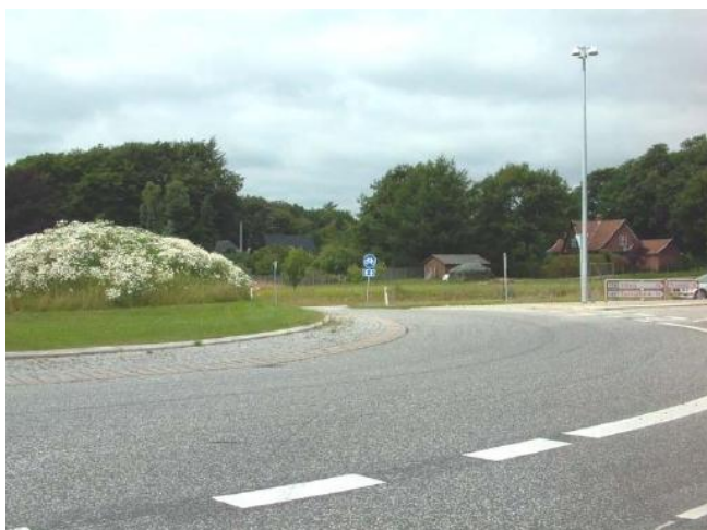
Rys.9.13. Rondo, jako metoda redukcji hałasu drogowego ( http://www.silence-ip.org/site/fileadmin/SP H/SILENCE H .D1 20070105 DRI Final.pdf )
