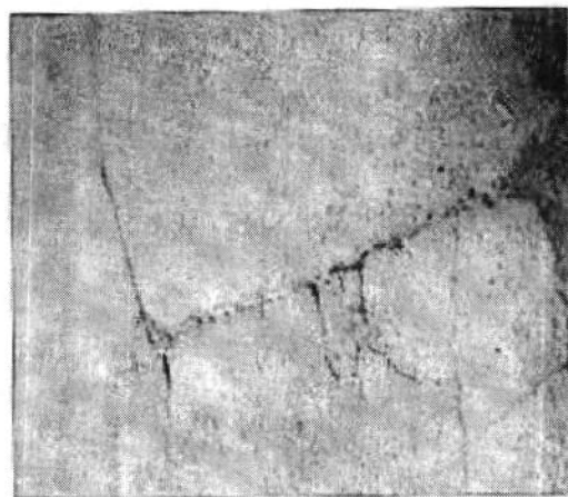
Rys. 6. Przykład spekania poprzecznego o średnim stopniu uszkodzenia
