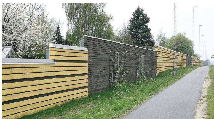
Rys. 10.16. Ekran przeciwhałasowy (cegła, drewno)
