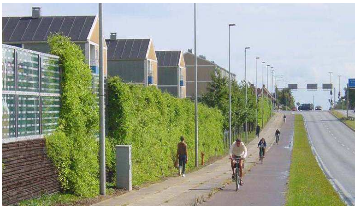
Rys. 10.17. Ekran przeciwhałasowy (przezroczysty, porośnięty roślinnością)
