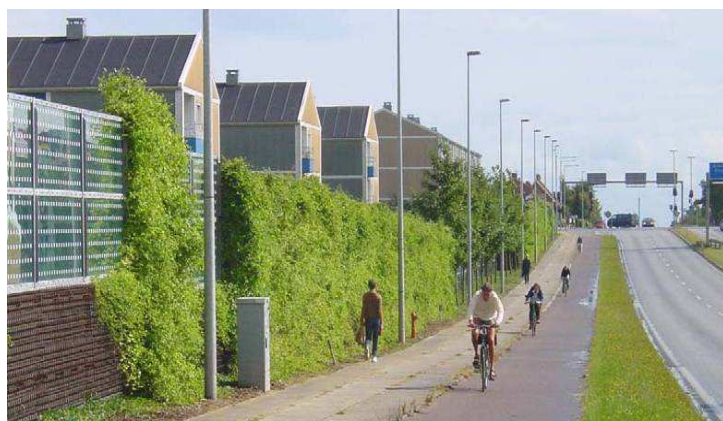
Rys. 10.17. Ekran przeciwhałasowy (przezroczysty, porośnięty roślinnością)
