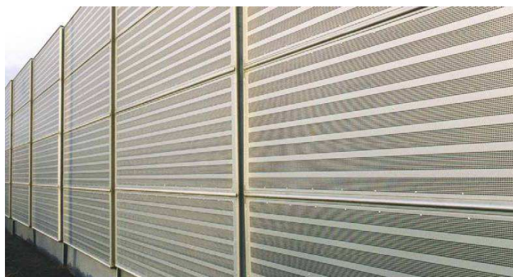
Rys. 10.18. Ekran przeciwhałasowy (dźwiękochłonny)
